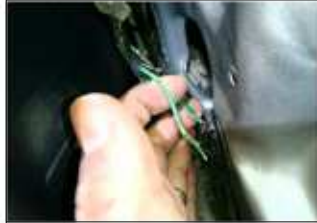
噛み切られた配線の1本
